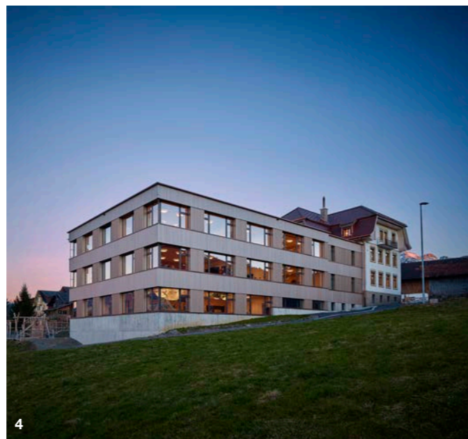
1 Construction d'un nouveau bâtiment scolaire sur le Plateau de Diesse, Prêles
