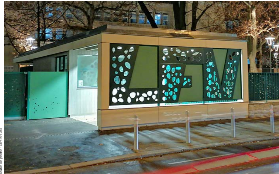
Loge du concierge avec accès.
