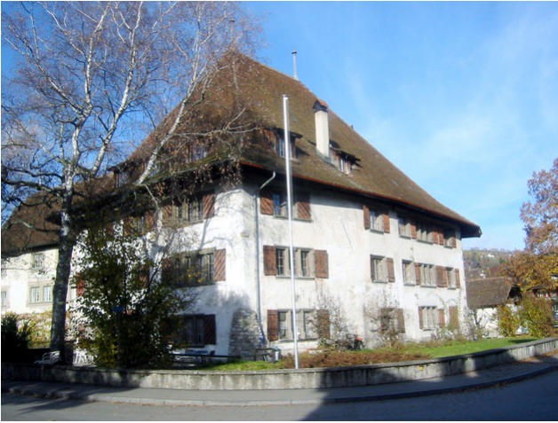
Außenbereich vor der Renovierung
