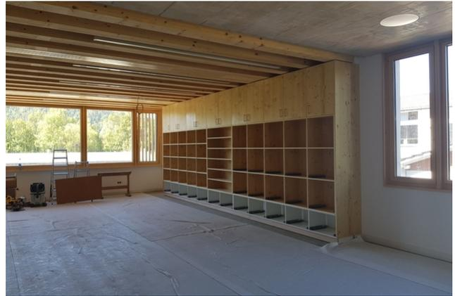
Das Dorf Courrendlin hat eine neue Sekundarschule erhalten, die mit dem bestehenden Schulkomplex verbunden ist. Es handelt sich um eine Hybridkonstruktion, bei der die Materialien Holz und Beton als tragende Struktur gemischt wurden.
