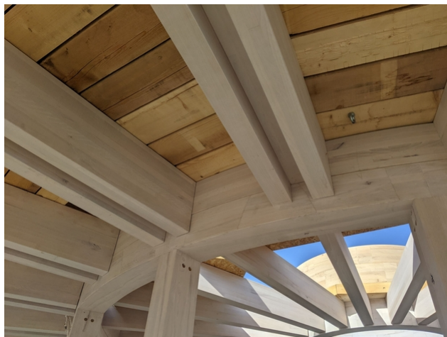
Poutres en bois de hêtre
