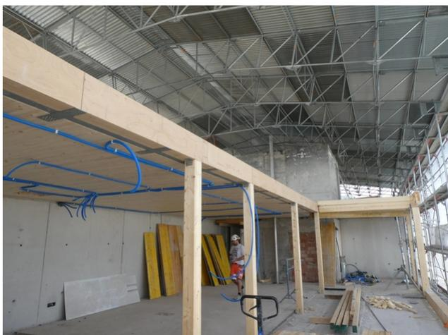
Surélévation sous le toit de secours
