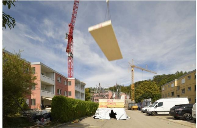
Un lotissement situé au cœur de la ville de Wetzikon dans le canton de Zurich a été rénové. Grâce à une surélévation en bois, 36 nouvelles unités d'habitation ont pu être créées sur les bâtiments préfabriqués de l'icône de la construction Ernst Göhner.
