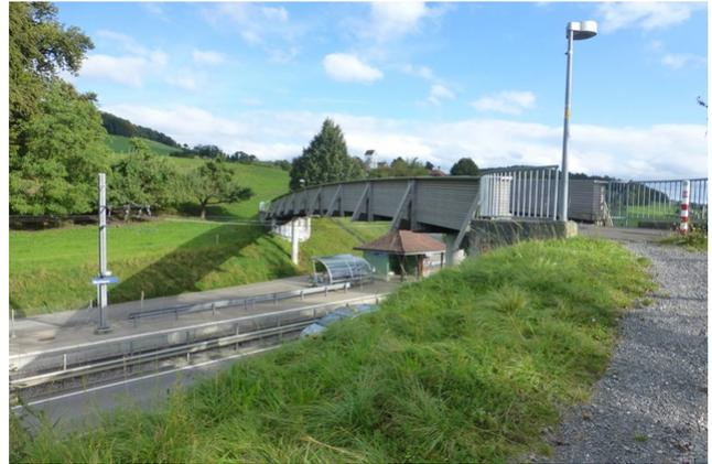
La passerelle pour piétons près de Vechigen a été construite en 1999. Vu de l'extérieur, il était en relativement bon état, seuls les recouvrements supérieurs des poutres principales semblaient altérés et endommagés.
