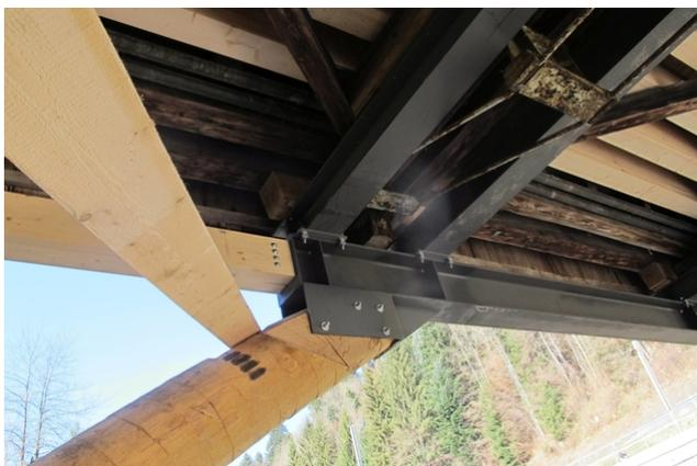
Raccordement des troncs de chêne et des barres de compression
