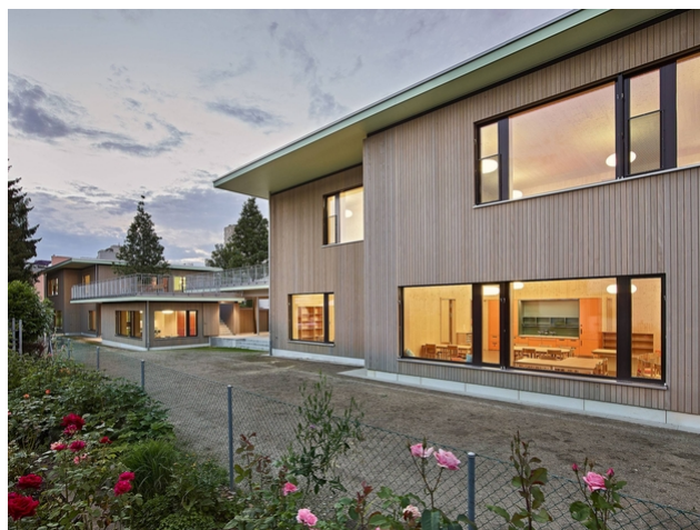
Le nouveau complexe de l'école maternelle se compose de plusieurs maisons en bois (Photos : Zeljko Gataric)
