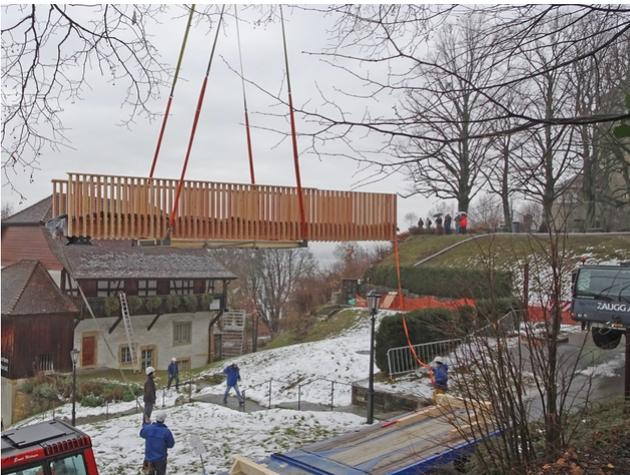
Une grue a soulevé le pont de 10,5 mètres de long jusqu'au bon endroit
