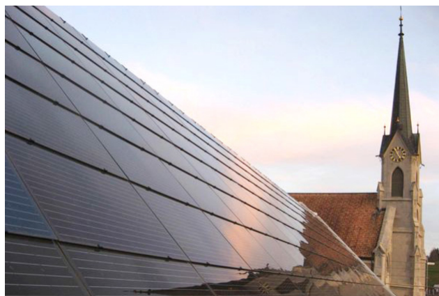
Toiture en éléments de bois avec installation photovoltaïque pour la production d'électricité
