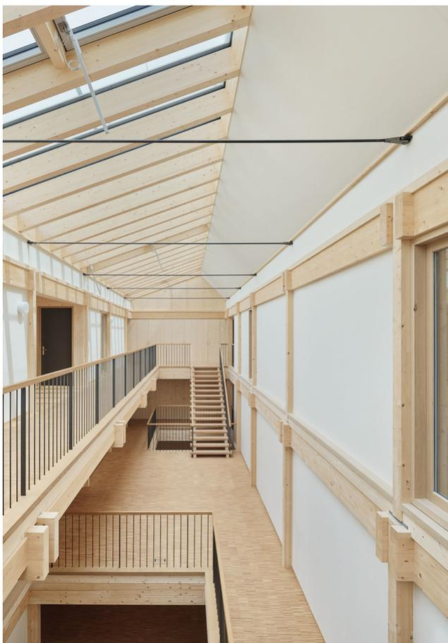
La structure porteuse est en bois, à l'exception des barres de traction.
