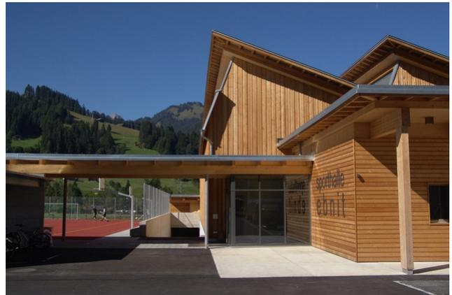
Le projet réalisé, un gymnase triple avec une charpente combinée en acier et en bois, est issu d'un concours d'architecture organisé en 2002. L'orientation du toit du shed vers le sud permet d'utiliser directement l'énergie solaire de manière passive.
