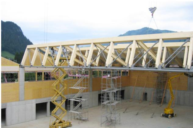
Montage de poutres en treillis
