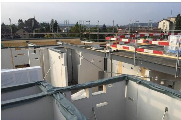
Installation de la poutre sous-tendue
