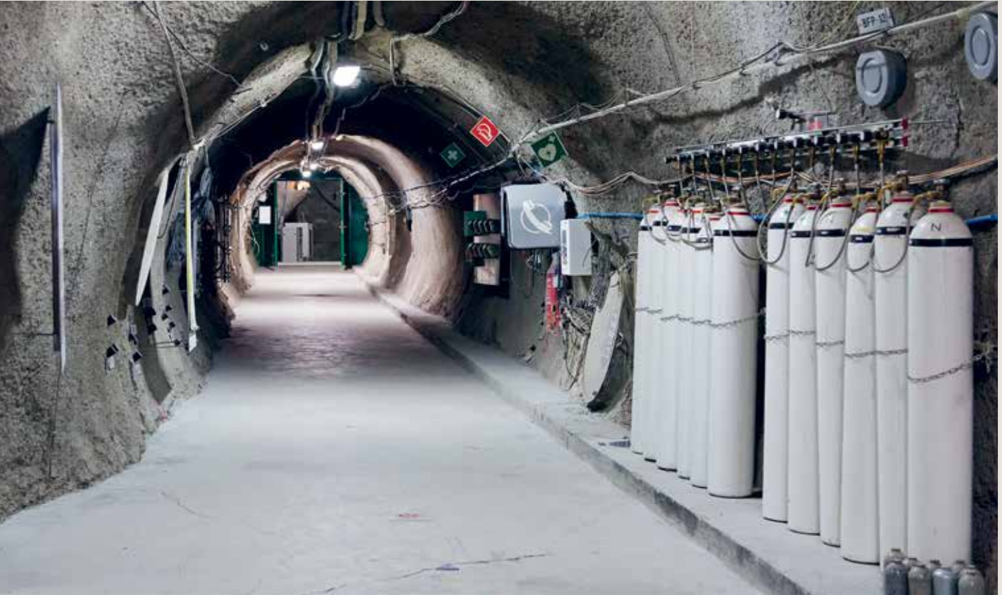
Im Felslabor Mont Terri (JU) wird untersucht, wie genau sich CO 2 dauerhaft im Untergrund speichern liesse.
