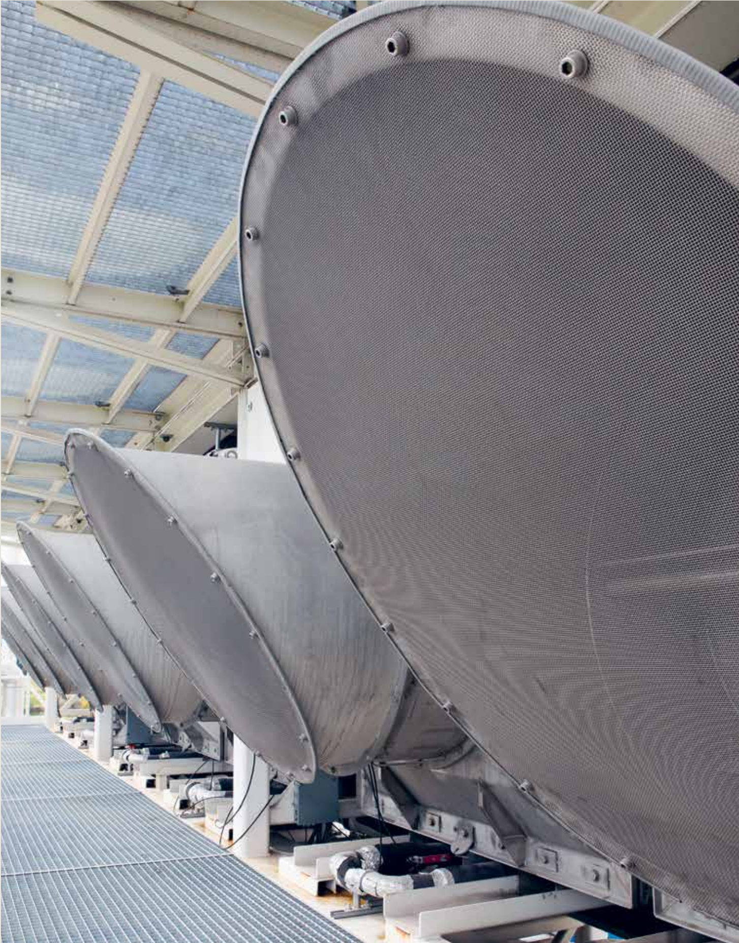
Die Anlage der Firma Climeworks in Hinwil (ZH) filtert jährlich 1500 Tonnen CO 2 aus der Luft.
