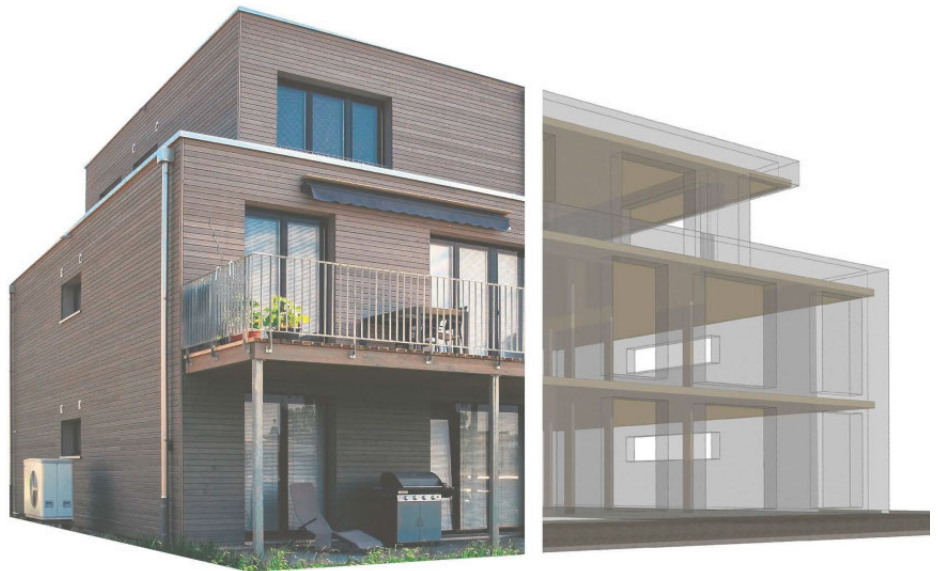
In Grossaffoltern baute Stuberholz vier Mehrfamilienhäuser mit 2140 m 2 TS3-Geschossdecken.
