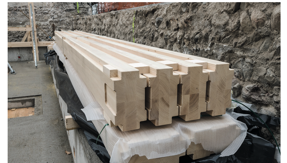
Der Querschnitt der bis zu acht Meter hohen Pfosten aus einheimischer Weisstanne zeigt die innere Struktur. Zum Schutz und aus gestalterischen Gründen sind die Kanten eingekerbt.
