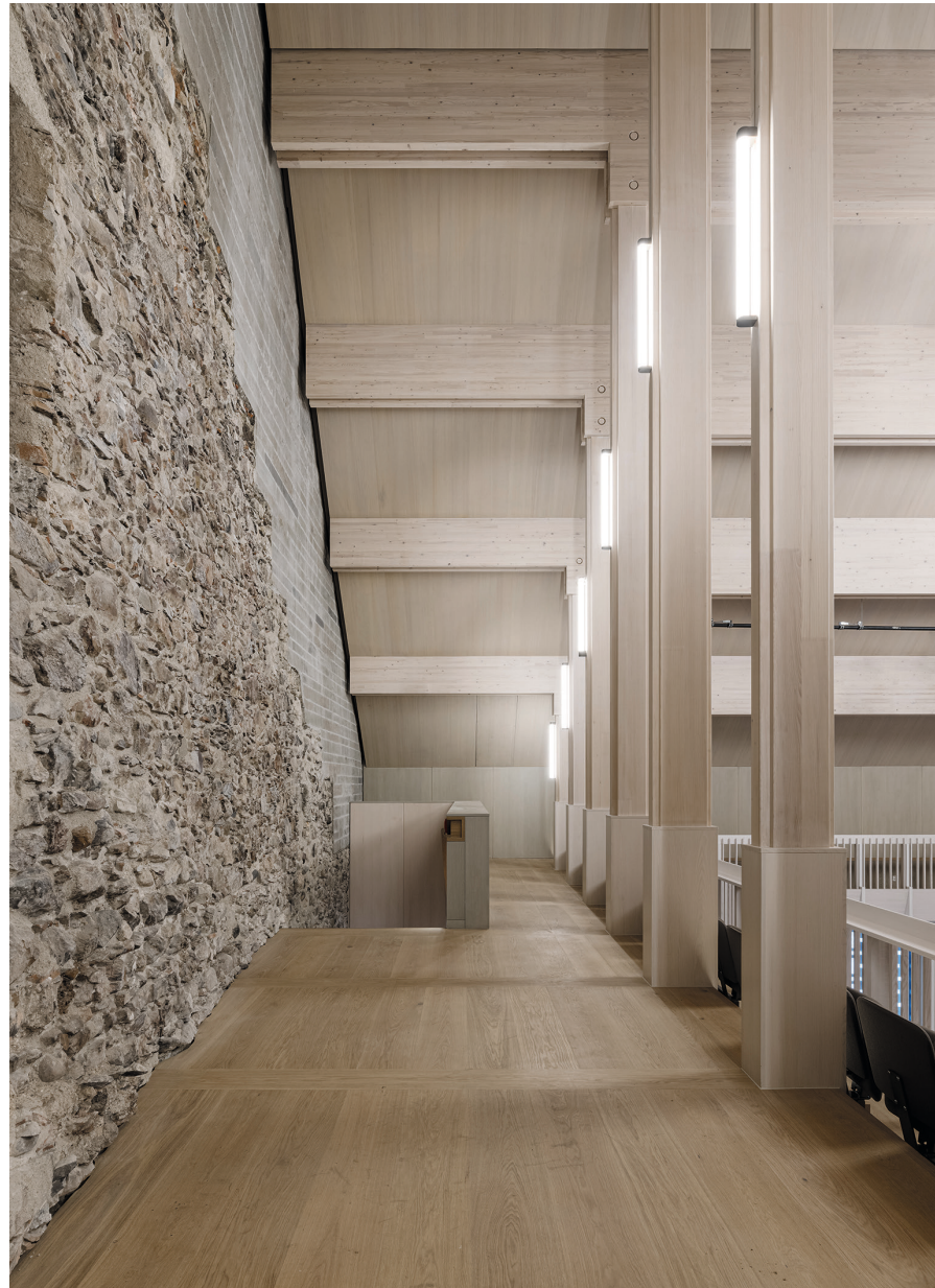
Die Balken sollten möglichst dicht an die historische Mauer anschliessen.
