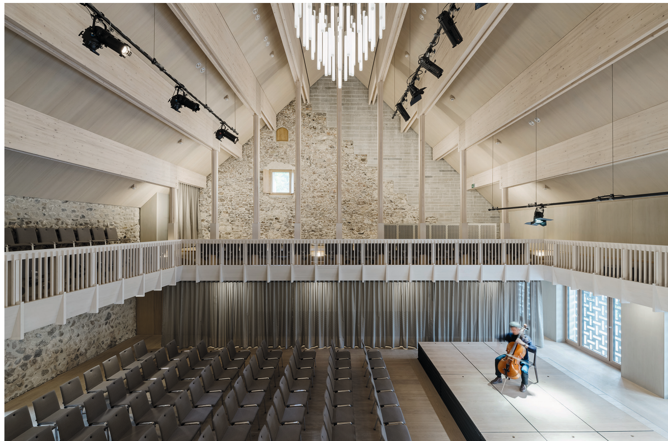
Das historische Landenberghaus in Greifensee erhielt eine neue Dachtragkonstruktion aus Weisstanne.
