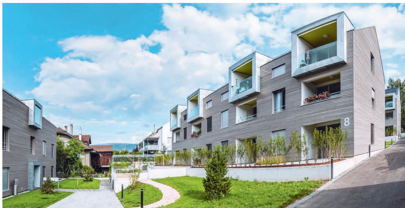
Die drei Baukörper mit ihren 27 Wohnungen sind barrierefrei verbunden. Die Fassade präsentiert sich mit einer vorvergrauten Schalung aus sibirischer Lärche.
