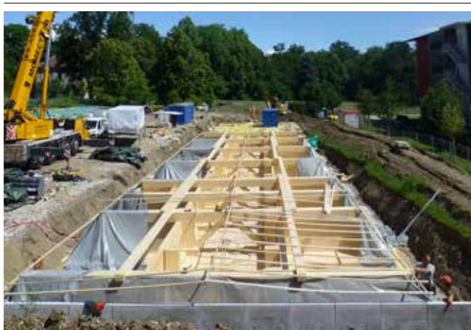
Chantier du centre d'hébergement de Rigot à Genève montrant la grille qui répartit le poids de l'ouvrage sur les pieux battus, avec au centre, une gaine technique enfoncée dans le terrain, réalisée en panneaux de bois lamellé croisé. (ACAU ARCHITECTES)
