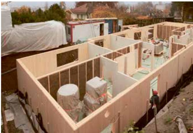
Photographie prise durant le chantier à Thoune, d'un projet conçu par le bureau HLS architectes. Des panneaux de bois lamellé croisé posés dans un terrain en pente forment une monocoque. (TIMBATEC/TIMBASE)
