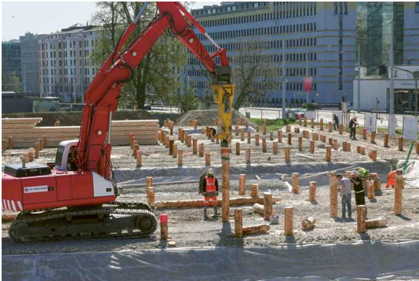
Les pieux de bois sont pertinents dans un terrain à faible capacité mécanique. Pour l'Opéra des Nations à Genève, 300 pieux provenant des forêts de Versoix ont été employés. Après démontage, ceux-ci ont été simplement abandonnés dans le terrain. (CHARPENTE CONCEPT)
