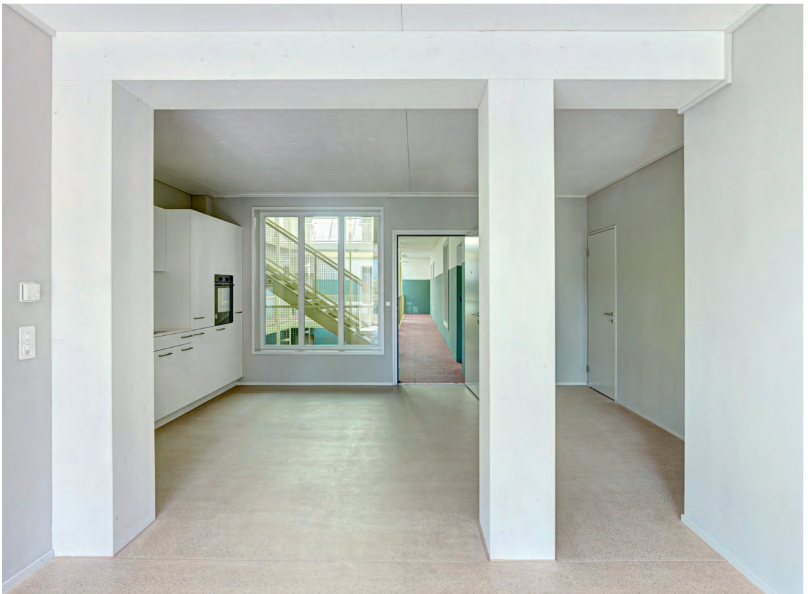
Ein Balken drückt die Decke, eine mächtige Stütze gibt den Wohnungen Halt: Die Holzbauweise verleiht dem wenigen Raum einen Rahmen.
