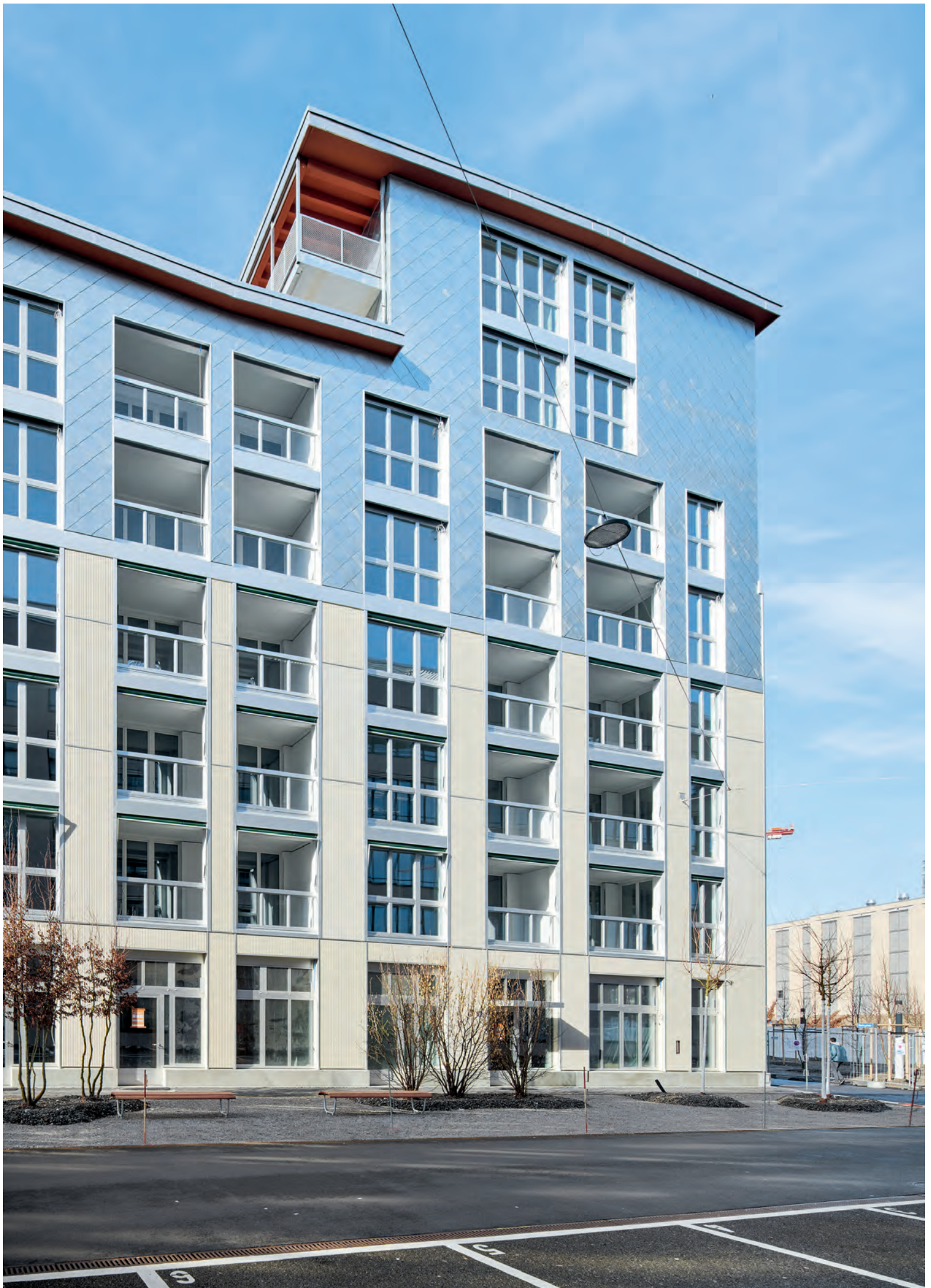
Die Fassade der Überbauung «Krokodil» auf dem Sulzer-Areal in Winterthur gibt sich industriell. Der Dachvorsprung weist orange leuchtend auf die Holzkonstruktion.
