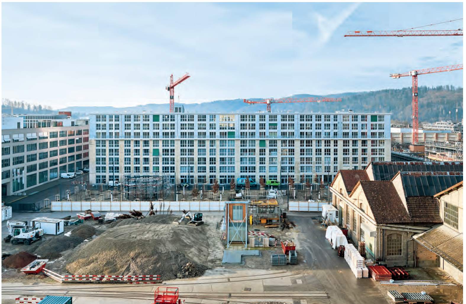
Auf dem Dialogplatz vor dem «Krokodil»-Gebäude wachsen reihenweise Bäume, rundherum wird noch an der «Lokstadt» gebaut.
