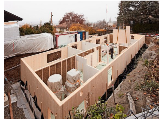
Rückblick auf die Bauarbeiten: Der «erste Keller der Schweiz ganz aus Holz» entsteht. Foto: PD/Timbatec
