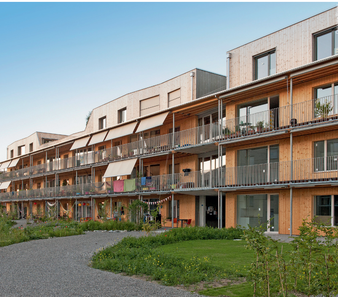
Umlaufende Balkone verhindern die sommerliche Überhitzung.
